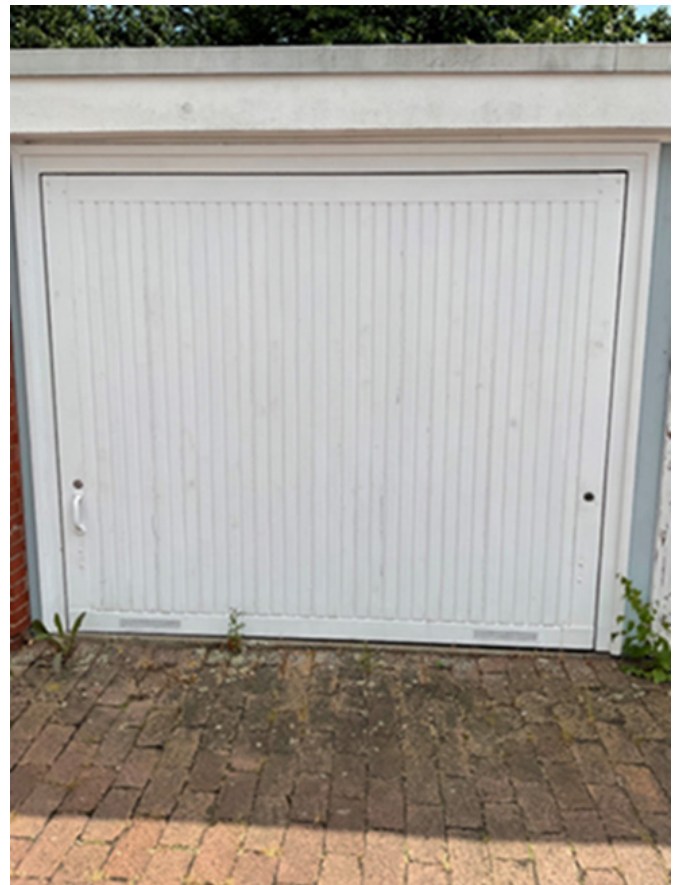
Abb. 18 Original Garagentor, heutiger Zustand
